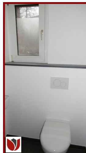
Saniert: Gäste-WC im EG
